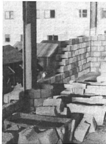
Ausmauerung des Stahlskeletts
